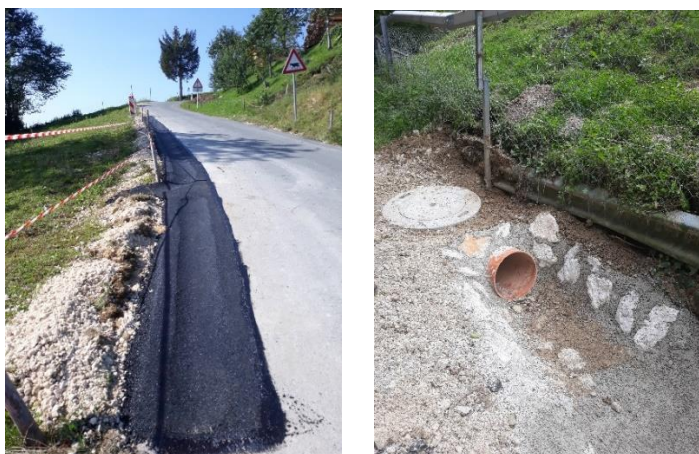
Sliki 16 in 17: Izgradnja mulde LC št. 440261 Brezje-Koroška vas in prepusta v Koroški vas LC št. 485051-Padeški vrh-Gorenje-Zgornje Zreče
