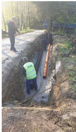
Sliki 56 in 57: Prestavitev kanalizacije
