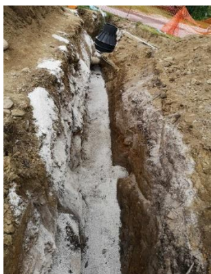
Slika 60: Sekundarna sanitarna kanalizacija »Kekl«
