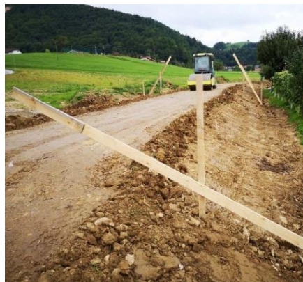
Slika 32: Izgradnja protipoplavnega nasipa
