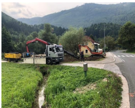
Slika 103: Sanacija vodovoda pri grobovih
