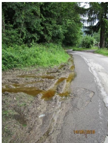
Slika 10: Poškodba bankine
