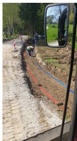
Sliki 56 in 57: Prestavitev kanalizacije
