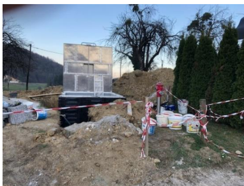
Slika 104: Izgradnja podpostaje v Gornji vasi
