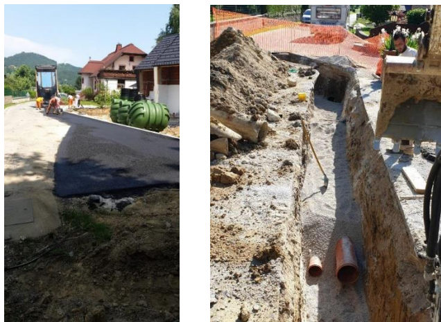
Sliki 58 in 59: Dogradnja meteorne in fekalne kanalizacije Kotnik
