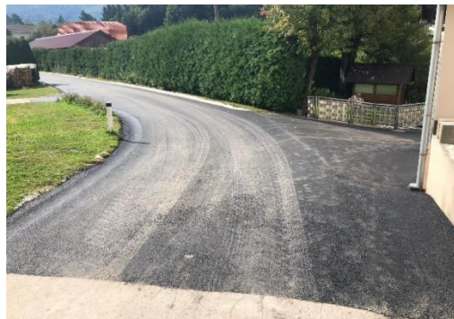
Sliki 101 in 102: Krpanje in sanacija javnih poti z asfaltom
