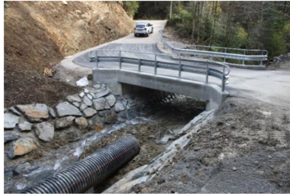
Slika 29: Most na Ločnici ob zaključku del
